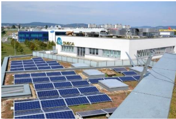
Omega setzt mit eigener Photovoltaik-Anlage auf alternative Energiegewinnung (Credit: Omega)
